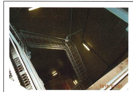
坑内の入るところは階段とコンクリート
